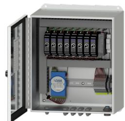
Sistema de relés y protección contra vibraciones de la serie VP para proteger maquinaria crítica contra vibraciones excesivas y fallas catastróficas.
